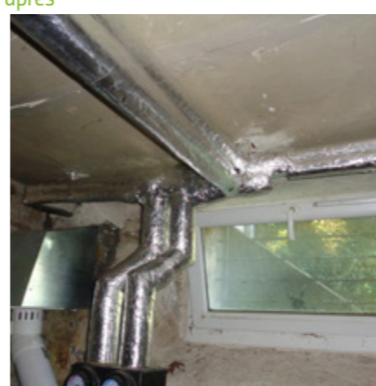
Saint-Martin-Sainte-Catherine calorifugeage avant / après
