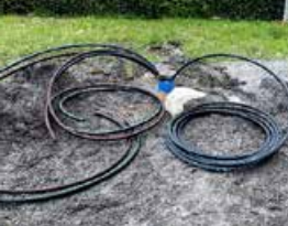
Cimentation en cours de la 1 ère sonde
