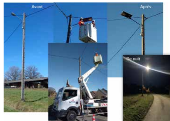
Situation avant, pendant et après installation
