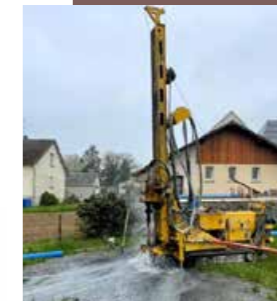
Forage à Moutier-Malcard Avril-Mai 2023 Au total, 3 forages de 117m sont réalisés.
