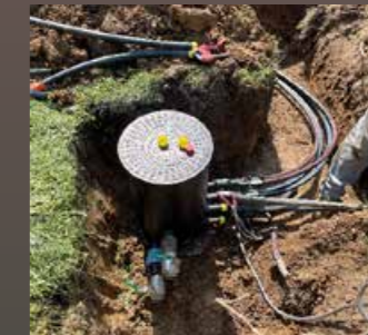
Pose du collecteur reliant les 3 sondes à la PAC
