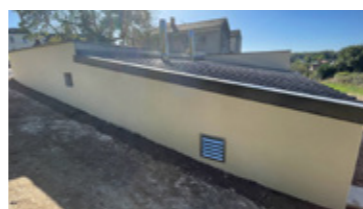
Local chaufferie et silo
